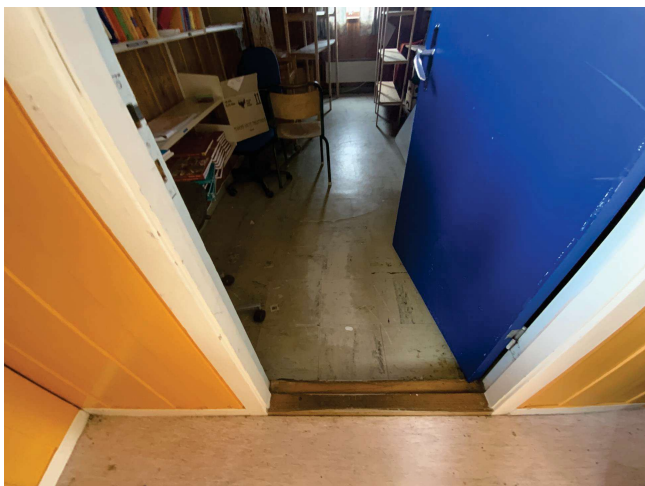
Beleggfliser som kan inneholde asbest.
