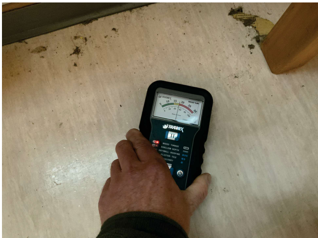
Ved yttervegg mot brua.
