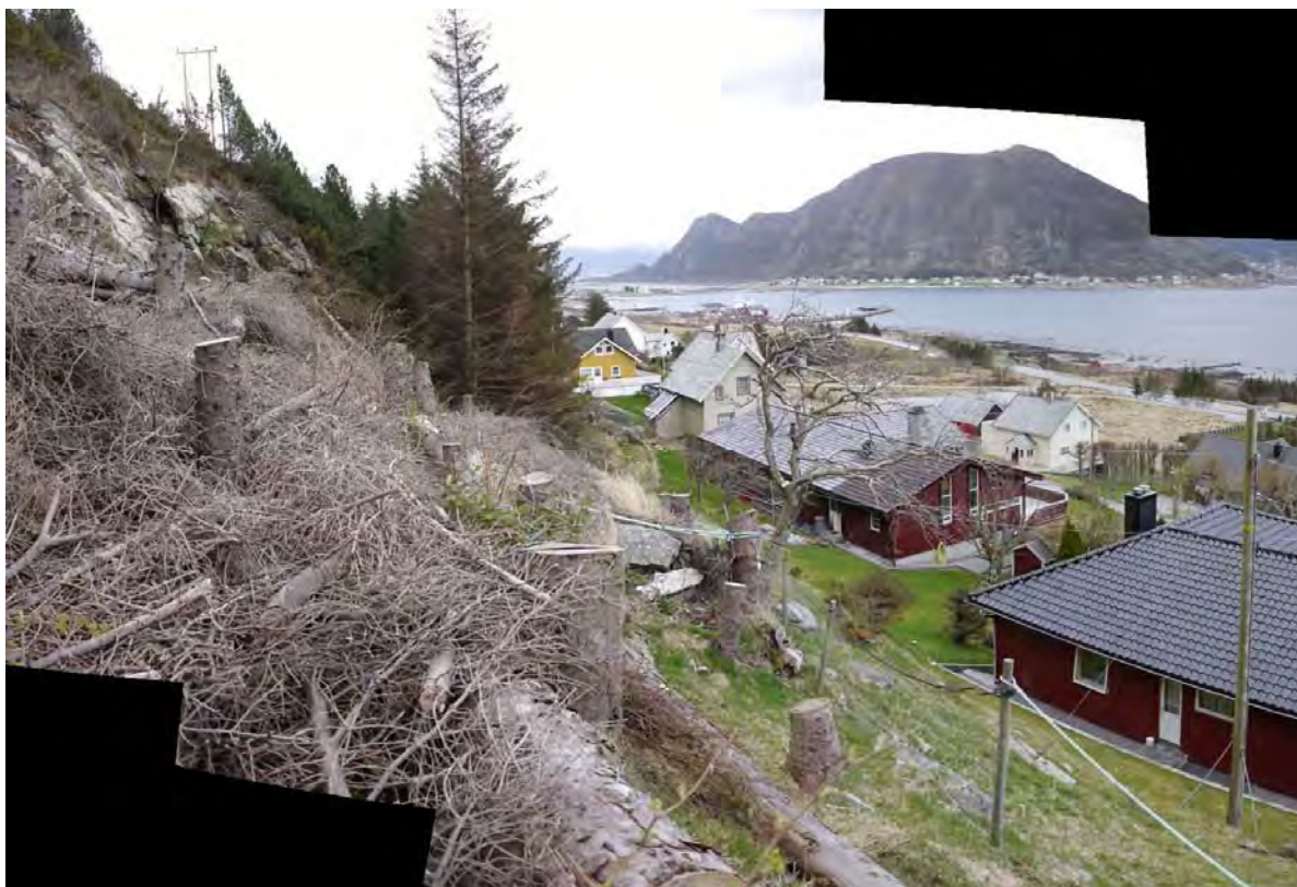
Figur 4.2.1 Oppsprukket løsneområde for steinsprang langs skrent til venstre i bildet. Her vises utfordringen med bartrærne som er falt på grunn av Dagmar i 2011 og plasseringen til bebyggelsen tett inntil skrenten.
