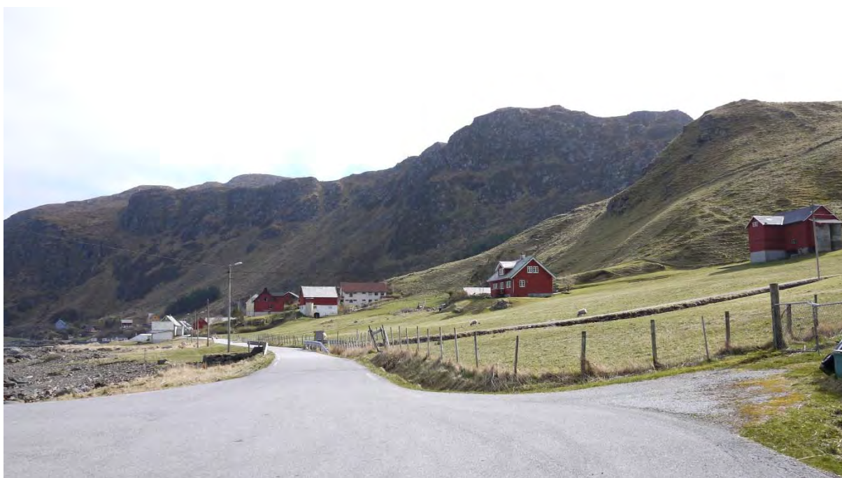
Figur 3.2.2 Fjellsiden under Storehornet er utsatt for steinsprang og snøskred. Bildet er sett mot sørøst.
