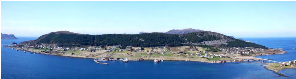
Figur 4.1.1 Remøy sett fra Leinehornet. Høyre del av bildet inneholder den kollapsede fjellsiden, mens den mest utsatte bebyggelsen befinner seg til venstre i bildet.
