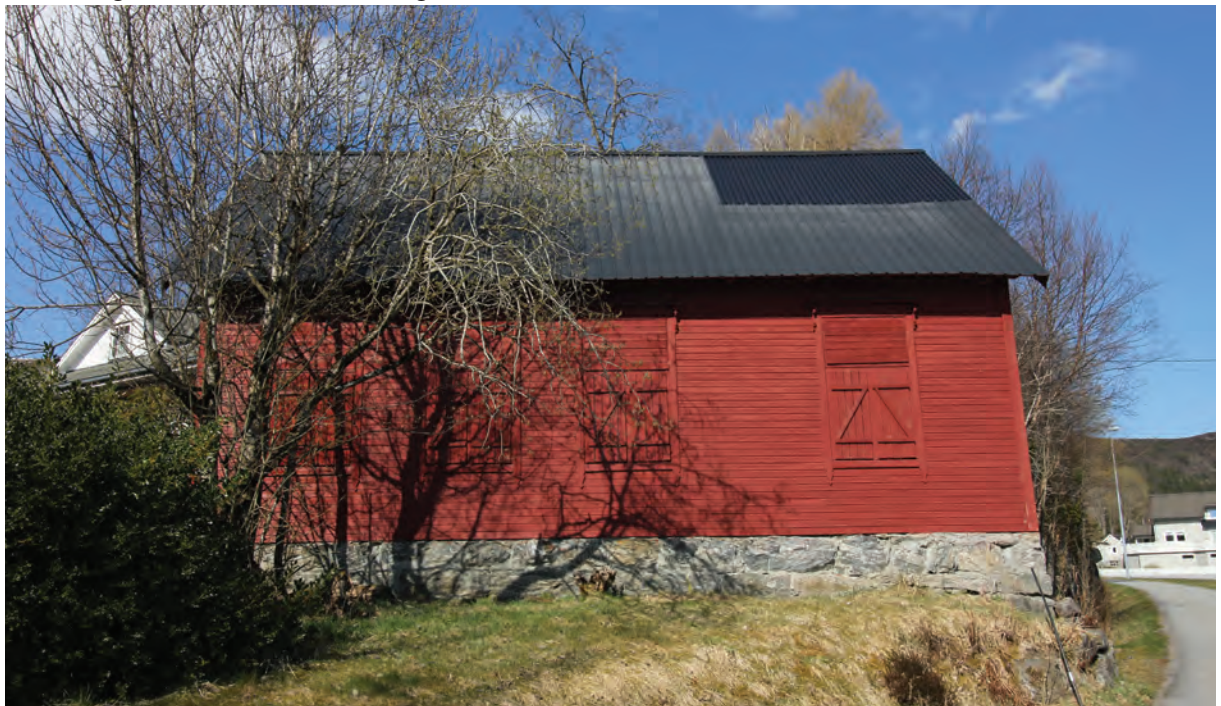
Under: Losjehuset i Leikanger. Den første losjen i Herøy, "Framtidsvon" vart oppretta i Leikanger i 1894. I 1911 stod losjehuset ferdig. Kulturminne ID 226958-1, regional verdi.
