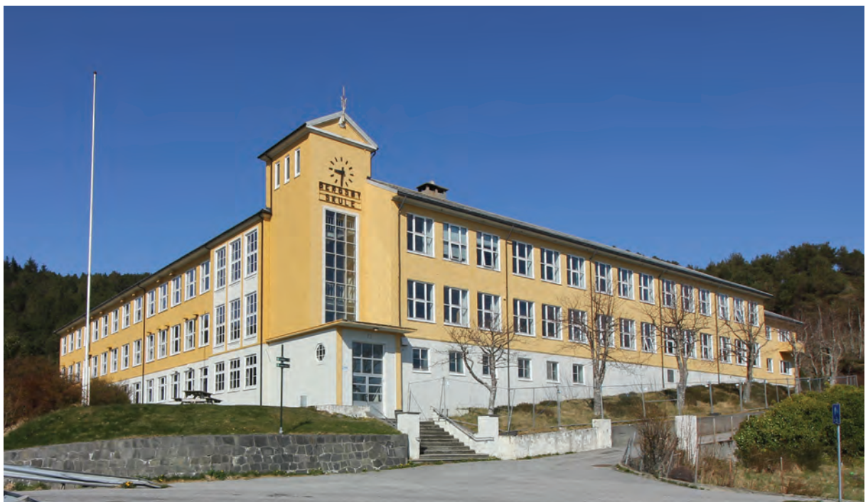
Over: Bergsøy skule, stod ferdig i 1957, grunna storleik og utsjånad kalla "Borga". Kulturminne ID 338382-0, lokal verdi.
