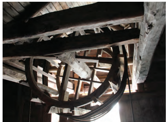
Vindehjul øvst i sjøbua, ein del av ein heisinnretning som har løfta varer inn og ut av bua.
