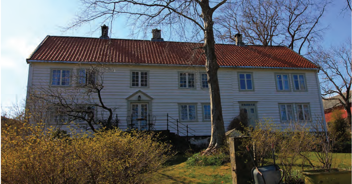
Herøy gamle prestegard, Raftenes, kulturminne ID 87253, nasjonal verdi.
