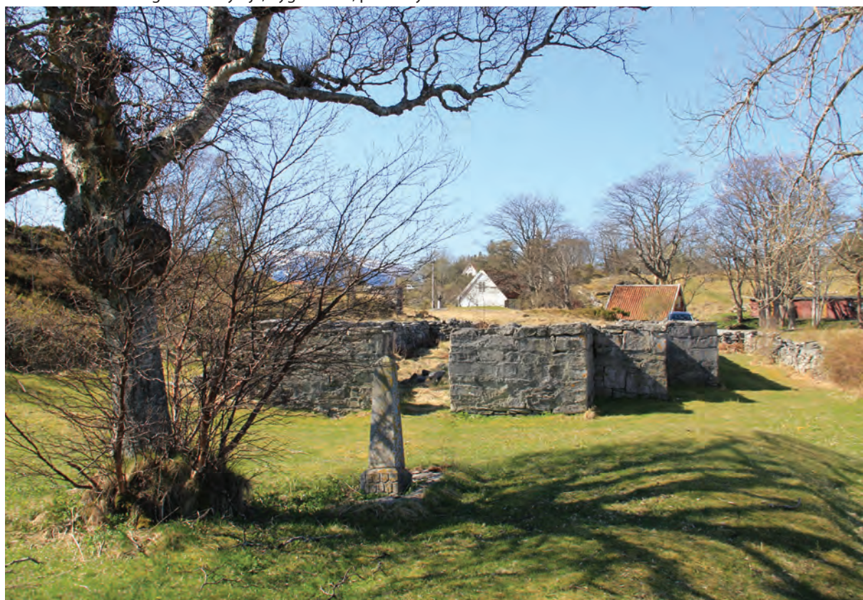
Grunnmuren til den gamle trekyrkja, bygd i 1859, på Herøyholmen. Kulturminne ID 84565-2.
