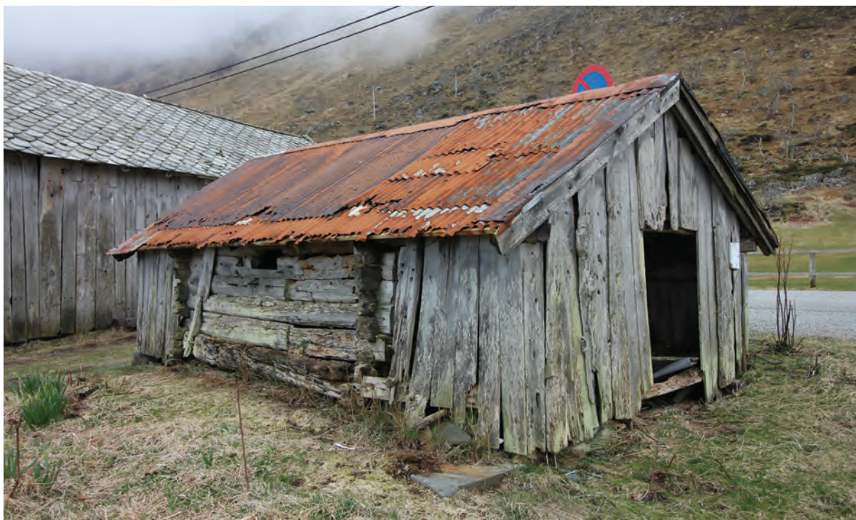
Lisjebuda, SEFRAK ID nr. 1515-0004-056, del av naustrekkeja i Goksøyra, kulturminne ID 338381-0. Sjøbu med lafta midtdel. Ho har vore nytta som husmannsplass og sengebud i periodar. Det er ukjent kor gammal bygningen er, men i utskiftings-papir frå 1850 vert nausta omtalt som dei "gamle nausta". Lokal verdi.
